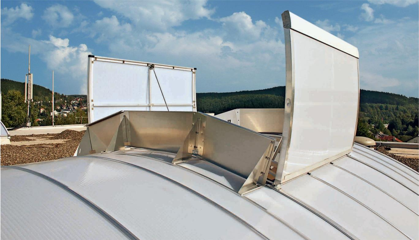
Öffnen sich die Rauch- und Wärmeabzugsanlagen, entweicht der Rauch und nahe des Bodens kann sich eine raucharme Schicht bilden.
